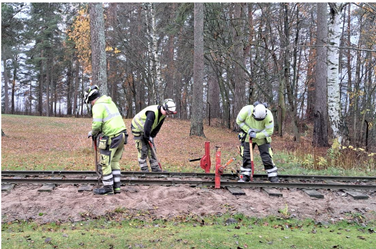
Banemontørlærlingene utfører sporjustering på "gammel måte" på Tertittbanen. Foto: Vasco T. Duarte (NJM)
