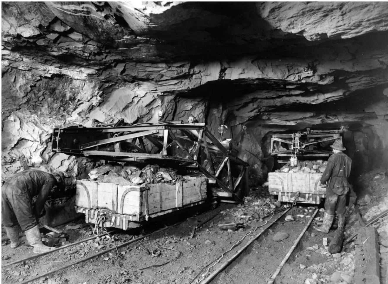
Anleggsvaggar vert lasta opp i stollen, Medjå tunnel 1926-32. Foto: Alf Schrøder, Norsk jernbanemuseum si samling.
