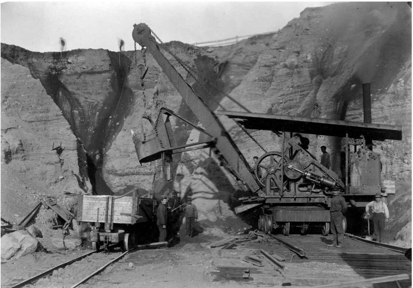
Opplasting av vaggar med Excavator gravemaskin «Saturnus» i Våttåbakkskjæringa i 1904. Dette var ei av landets fyrste gravemaskinar.
