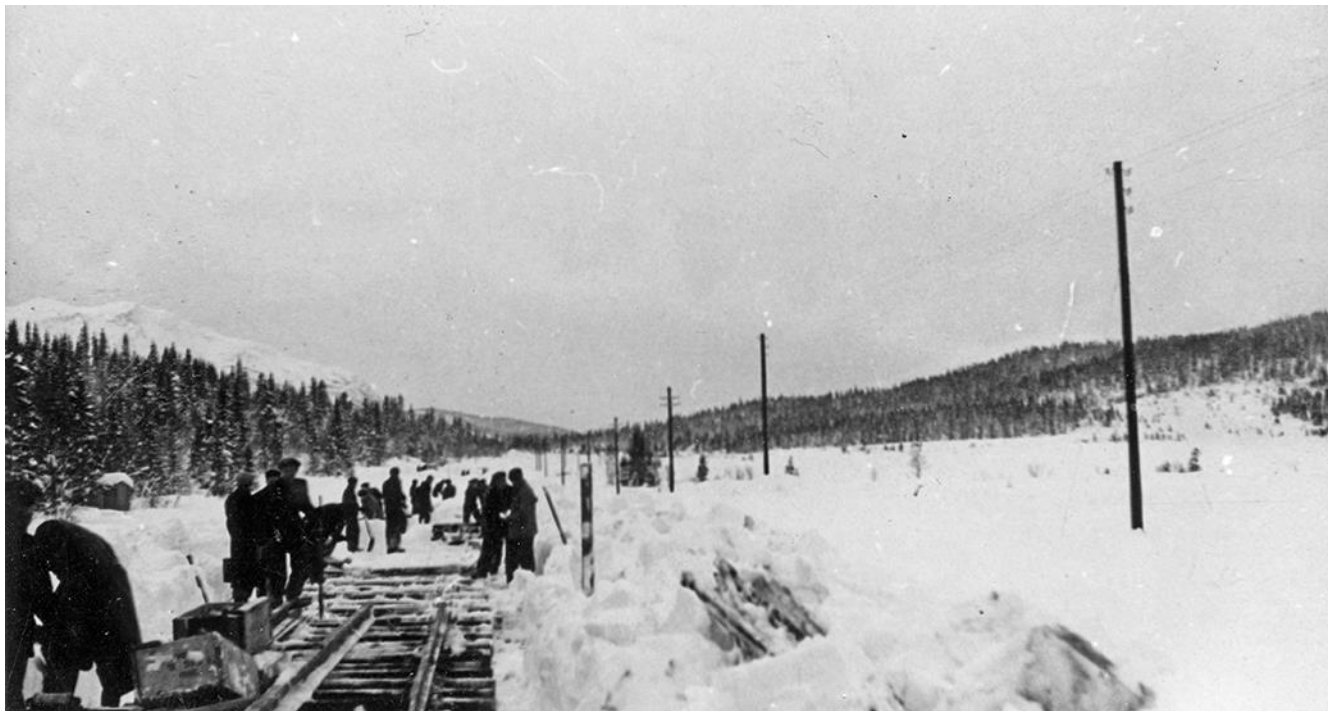
Skjeneleggjing vinteren 1941-42 ved Drevvatn stasjon. Norsk jernbanemuseum si samling.
