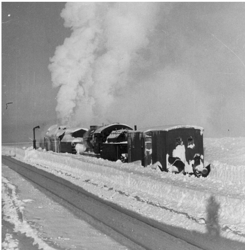
Damplokomotiv, roterande snøplog og sporreinskar i arbeid på Saltfjellet vinteren 1949.
