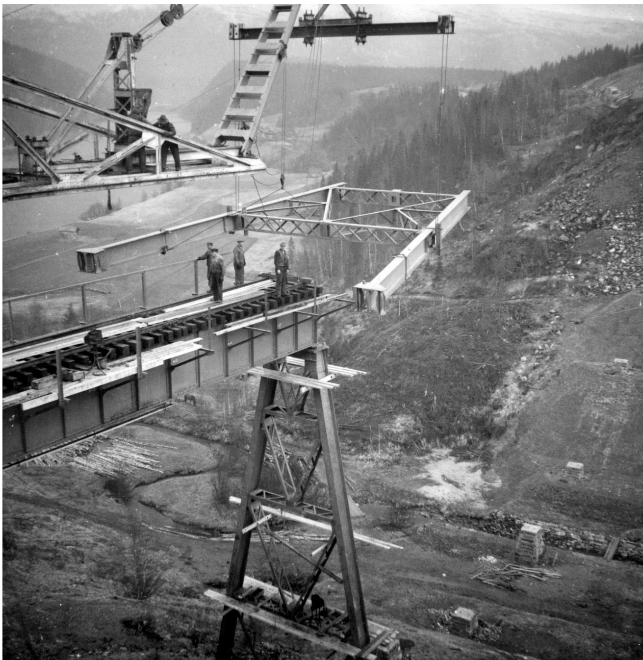
Montering av pilar 3 på Trolldalen viadukt 4. mai 1938. Norsk jernbanemuseum si samling.
