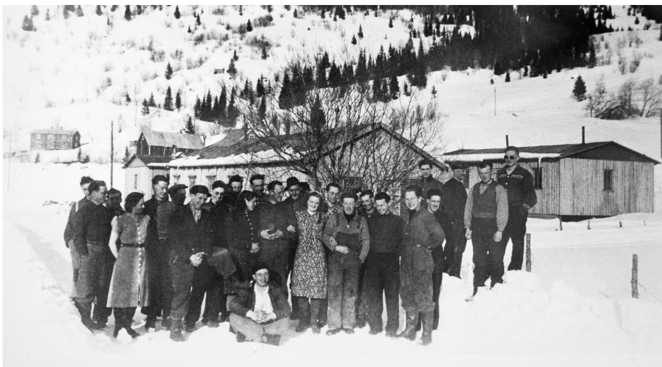
Kokkar og anleggsarbeidarar framom brakkeriggen nord for Bjerka bru 1940-45. Foto: Fridtjof Bakken, Norsk jernbanemuseum si samling.
